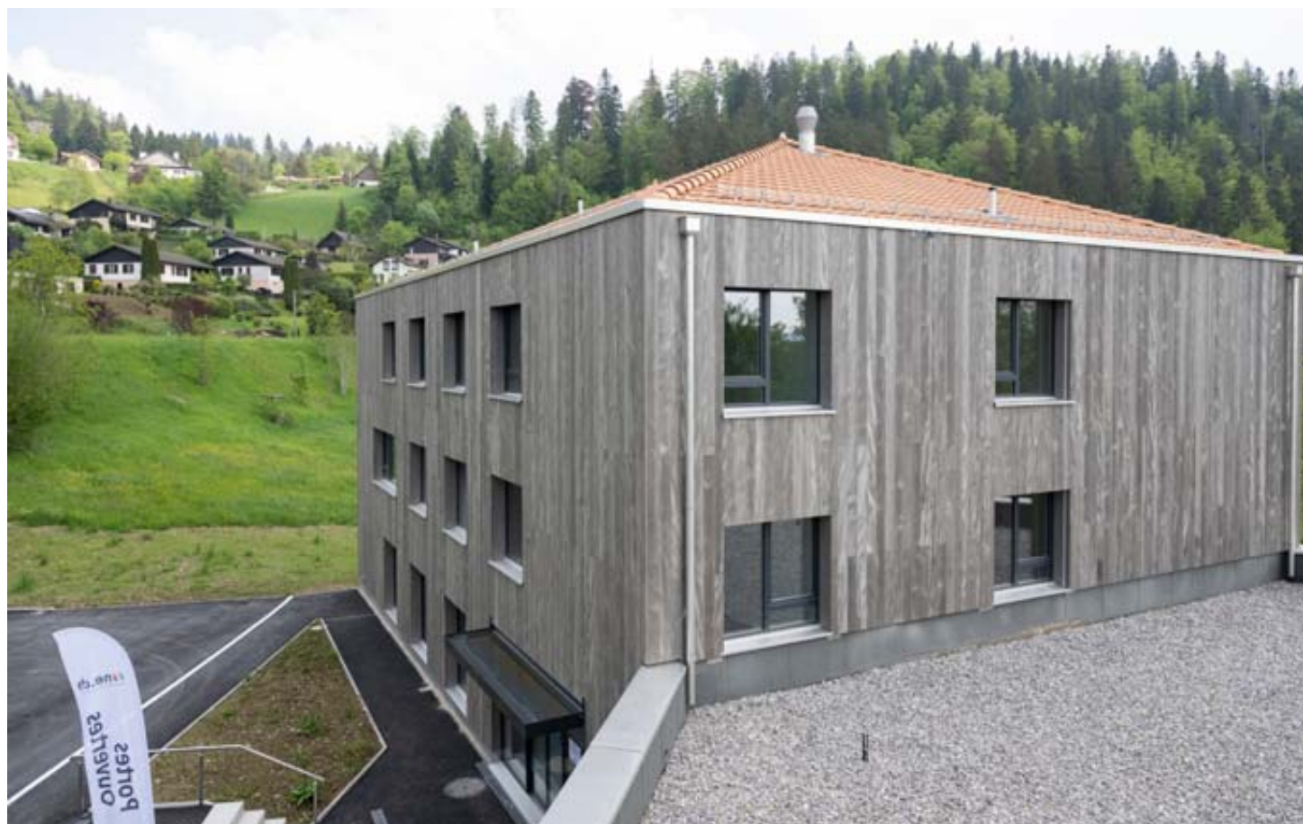
Située entre la forêt et le Doubs, à 500 mètres des commerces, la résidence Bel Air accueillera ses premiers locataires le 1er juin. LUCAS VUITEL
